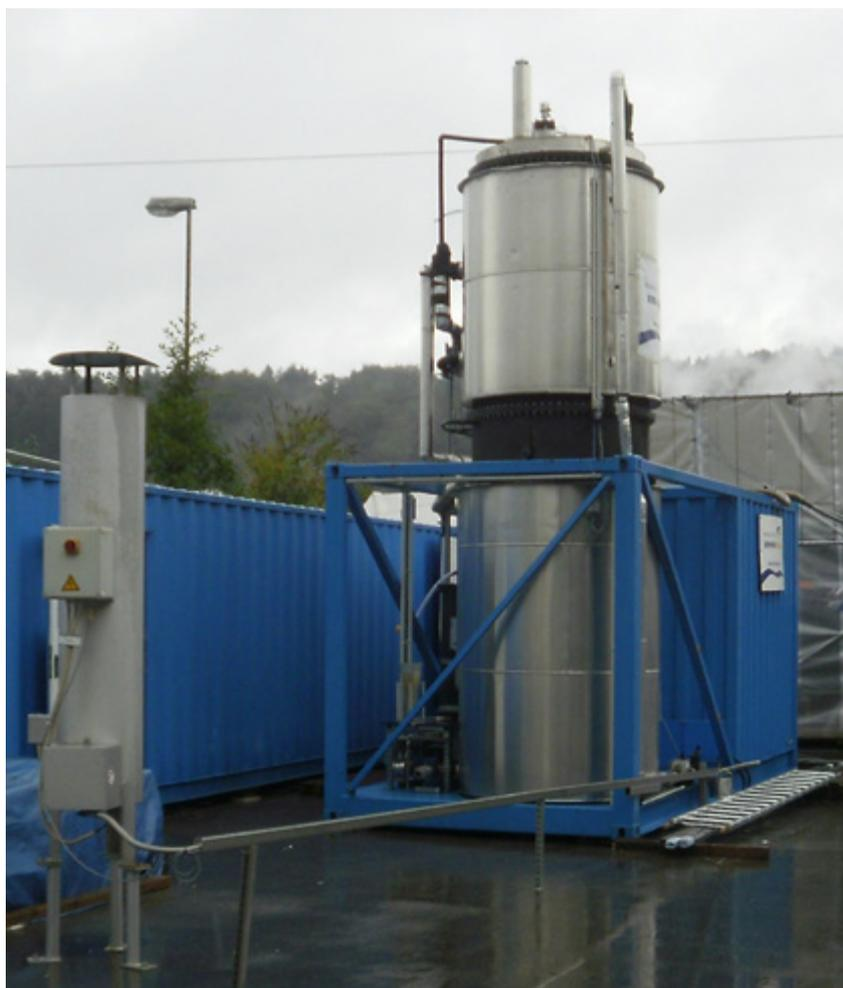
Fig. 4 Impianto di tipo UASB per il trattamento anaerobico con recupero di metano dai reflui di una cartiera tedesca, realizzato da Envirochemie nell'ambito del progetto europeo (7<sup>th</sup> FP) Aquafit4use di cui ENEA è stata partner
